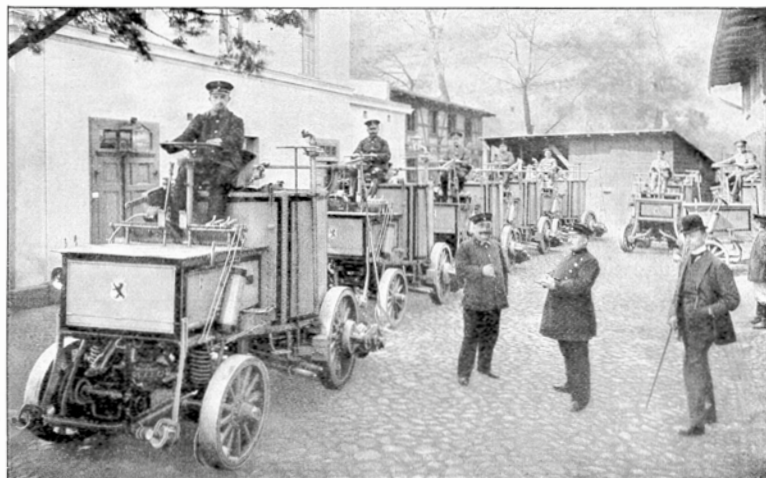
Fig. 782. Zug aus 7 elektrischen Straßenwaschmaschinen der Stadt Berlin im Begriff das Depot zu verlassen.
