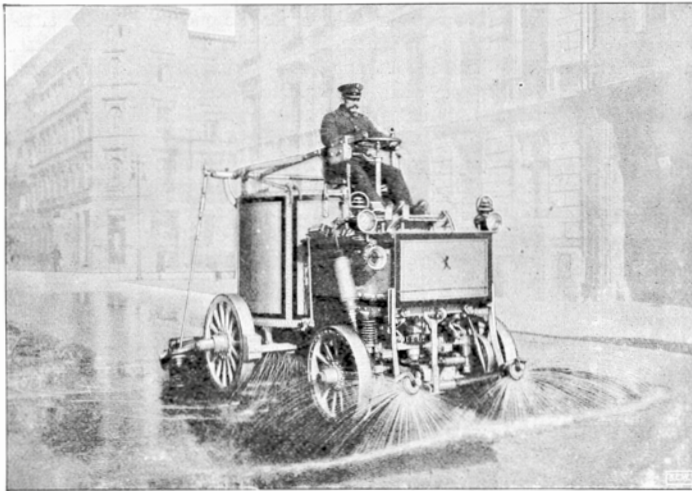
Fig. 779. Spülwagen mit elektrischem Antrieb des Städtischen Berliner Straßenreinigungswesens.
